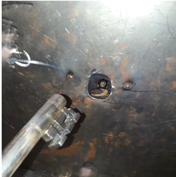
Abbildung 23: Schweißpunkte an ursprünglichen Nietverbindungen
