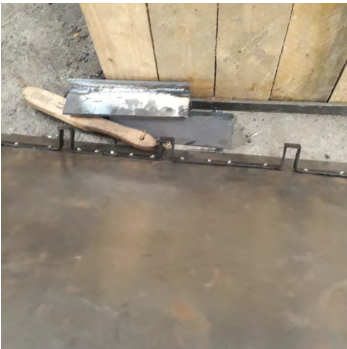
Abbildung 17: Einnieten des Rahmens auf neues Blech
