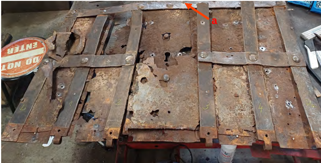
Abbildung 24: Demontage der Beschläge und Bänder
